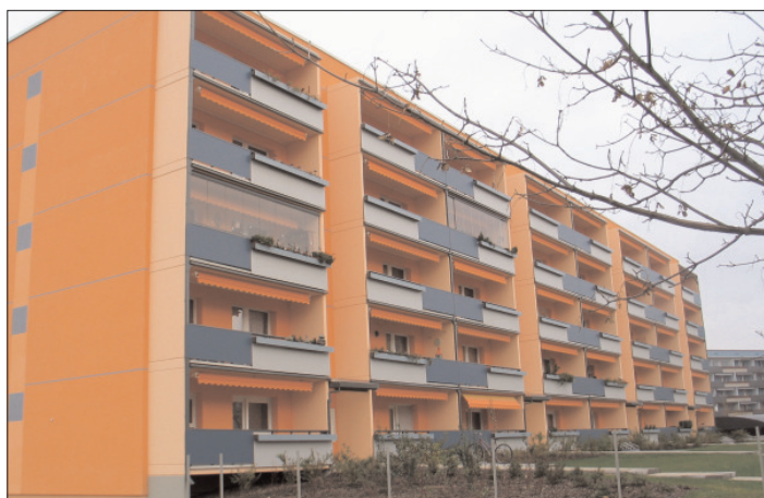
Schönes Wohnen nach der Sanierung von achtzig Einheiten auf der Friedrich-Ebert-Straße in Bautzen.
